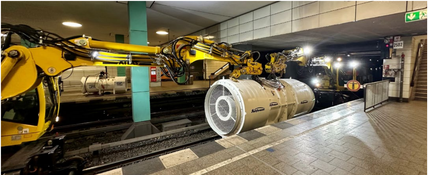
Abb. 2: Lüfterpositionierung während der Aufbauphase durch Einsatz eines Zweibegebaggers
