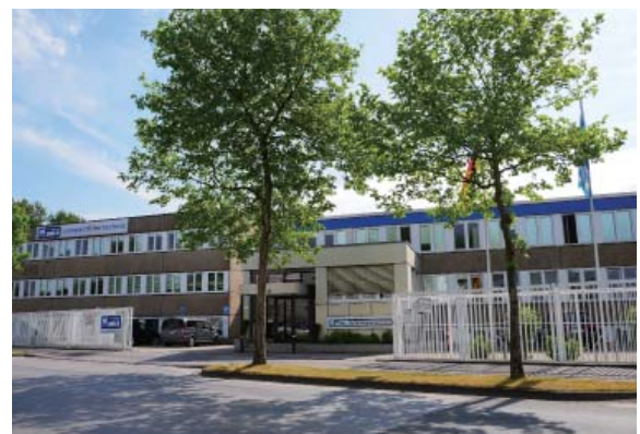
Zentralgebäude der CFH Gruppe in Deutschland
